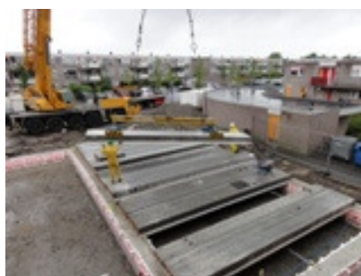
De betonnen vloerplaten
