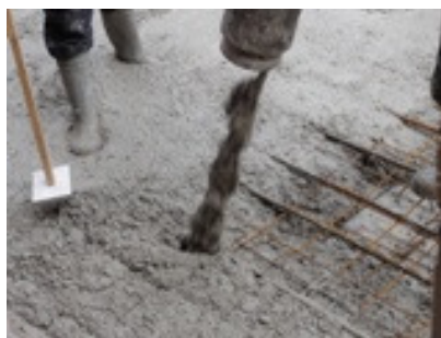
Het starten van de vloer
